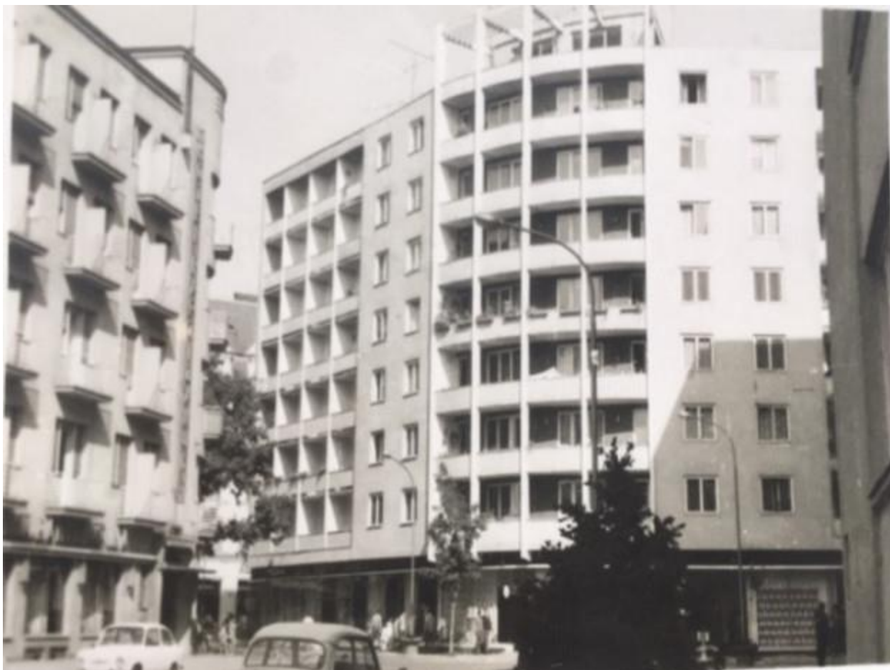
fig. 13- Bloc Locuințe str Piatra Craiului, Timișoara (sursă: arhiva Radoslav R)
